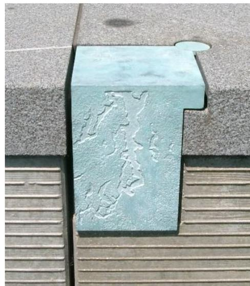
Am Anfang stand die Satellitenaufnahme als Vorlage für den Datensatz zur Herstellung eines 3D- Gussmodells. Die Oberplatte mit Information Ort, Breiten- u. Längengrad und das mit 150 verschiedenen Aufnahmen in einer 2 Km langen Mauer auf dem ehemaligen BUGA-Gelände in München Riem installiert
